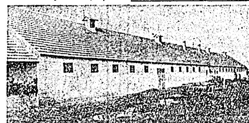
În cel mult două săptămâni aceasta va fi gata, putând adăposti scroafele mame și purceii. Salvații pentru oi va fi construit în cursul anului viitor.
