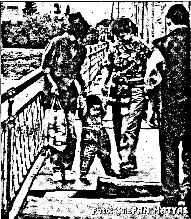
Traversarea podului „Traian” poate deveni o problemă de viață și de moarte, dacă găurile nu vor fi acoperite.
