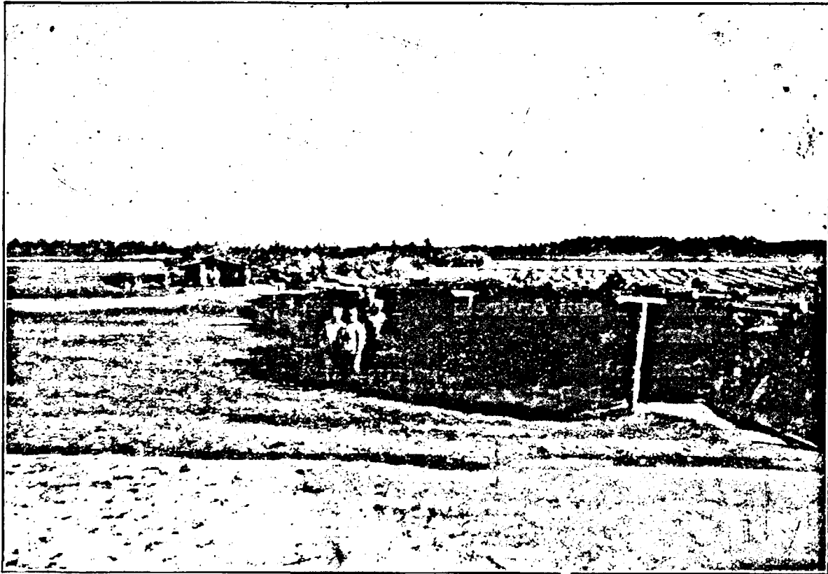
Locuințele eroilor. Tranșeele reg. 64 în Polonia.
