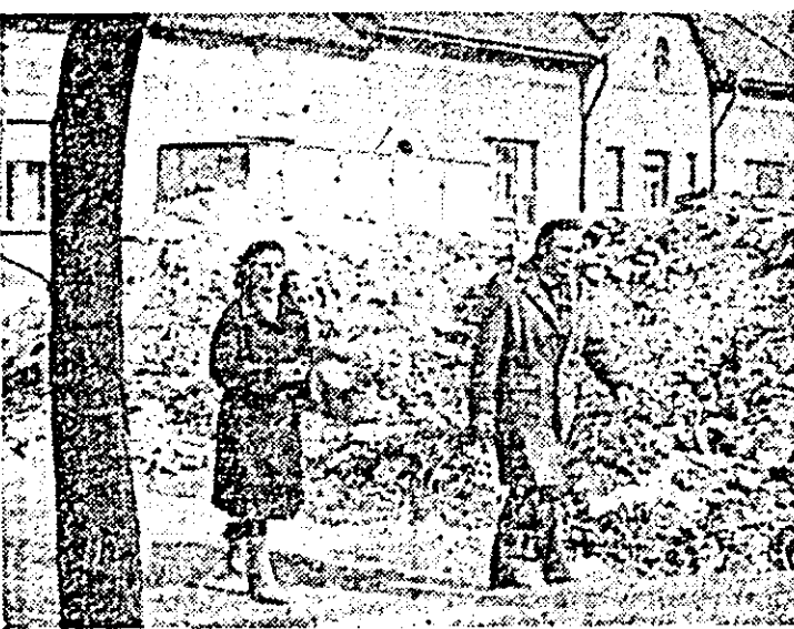
Pe strada Mărășești, colț cu E. Polier, de peste doi ani a fost demolată o clădire. În locul ei mormanele de moloz și gunoie cresc, și cresc, și cresc...
