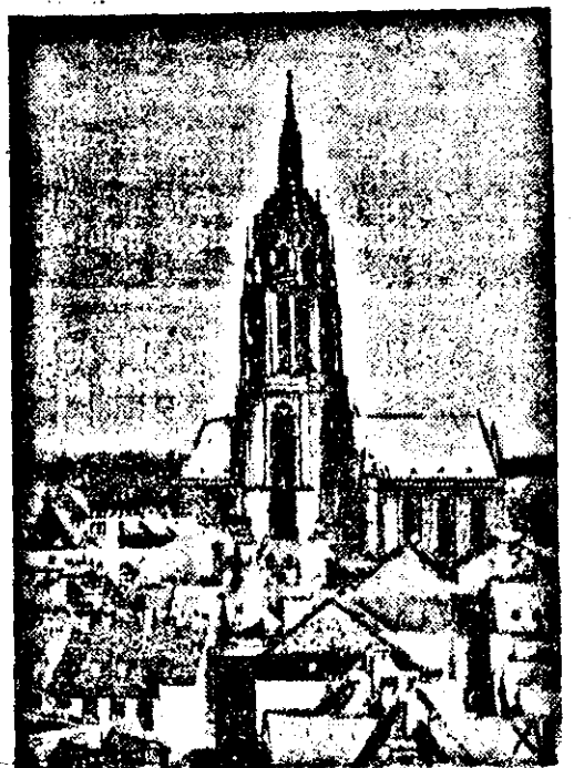
Der Frankfurter Dom, der durch amerikanische Luftangriffe schwer beschädigt wurde. (Orbis)
