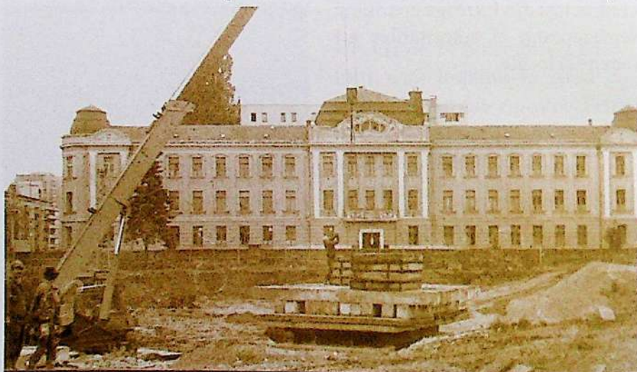
Pregătirea terenului de fundare a Catedralei
