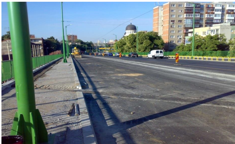
Foto 224. Viaductul Grădiște, în curs de finalizare a lucrărilor.
