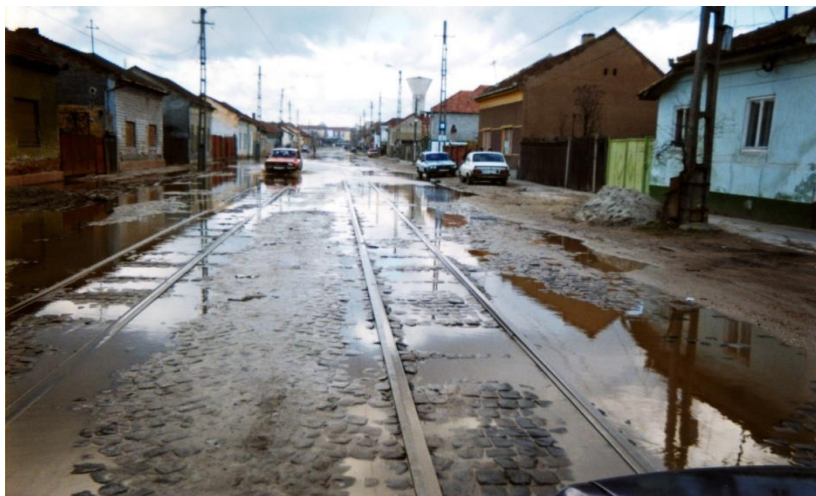
Foto 207. Strada Cocorilor în anul 1996, înainte de reabilitare.
