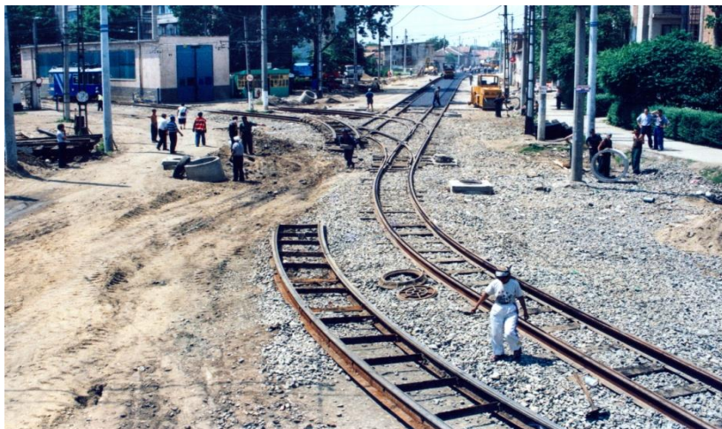
Foto 209. Lucrări de montare a macazurilor, la intrare în depoul UTA din str. Cocorilor (imagine surprinsă în anul 2003).
