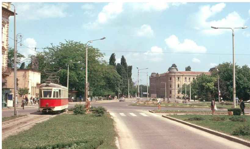
Foto 77. Tramvai Pullman în P-ța Podgoria. În partea stânga a imaginii, mica clădirea reprezintă prima stație de redresori pusă în funcțiune în anul 1946, stație ce alimenta rețeaua de contact pe întreg tronsonul Barieră Gai pod Traian (1973).
