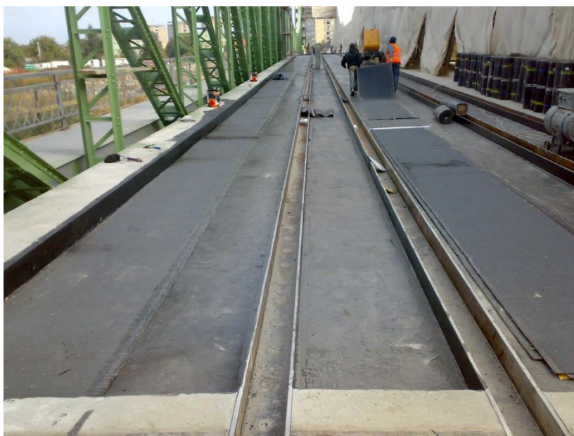
Foto 219. Lucrările de montare a șinelor pe podul Traian, prin fixare cu rășini în jgheburile din imagine (fotografie surprinsă în anul 2011).
