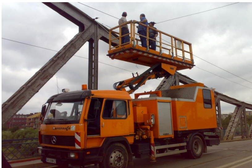
Foto 220. Montarea firului de contact de către echipa C.T.P. pe Podul Traian în cadrul lucrărilor din anul 2011.
