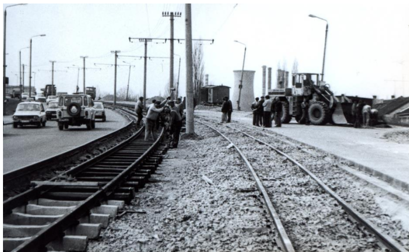
Foto 202. Reparație la linia de tramvai pe viaduct Micălaca, în anul 1993.
