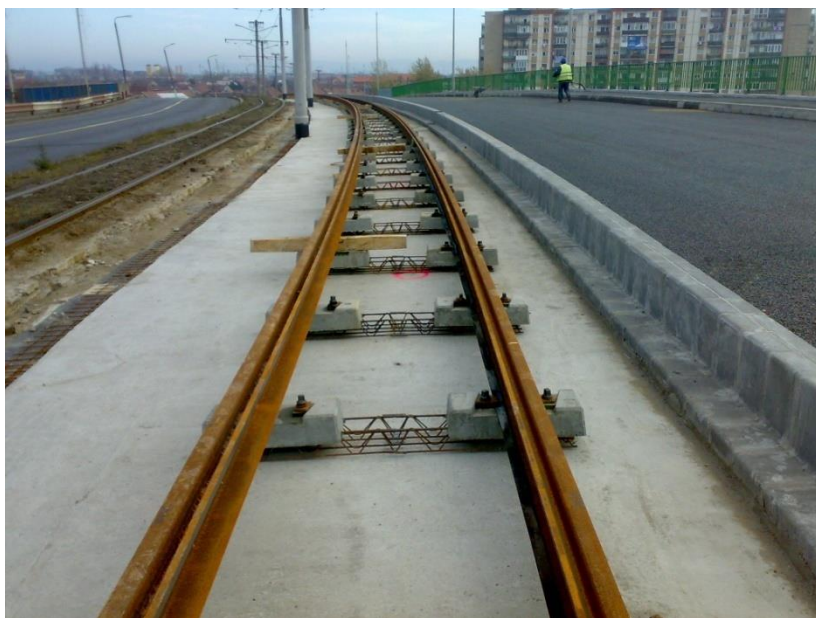
Foto 225. Viaductul Micălaca – montajul șinelor (imagine surprinsă în anul 2012).
