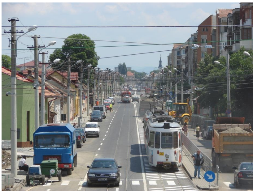
Foto 212. Strada Kogălniceanu, după reparație (imagine surprinsă în anul 2008).
