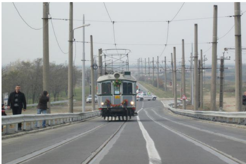
Foto 226. Recepția lucrărilor la viaductul Ghioroc, în data de 14 noiembrie 2015, probe efectuate cu vagonul istoric Ganz.
