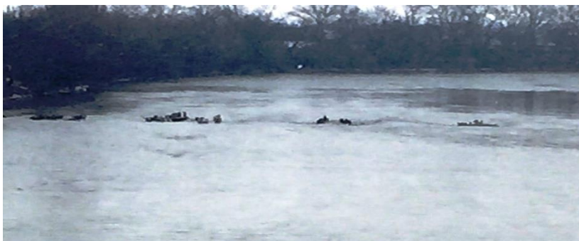
Foto 17. Foștii piloni ai podului de lemn (vedere actuală).
