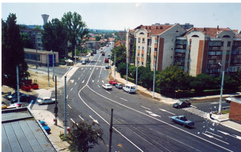
Foto 208. Strada Cocorilor, după reabilitarea finalizată în anul 2004.
