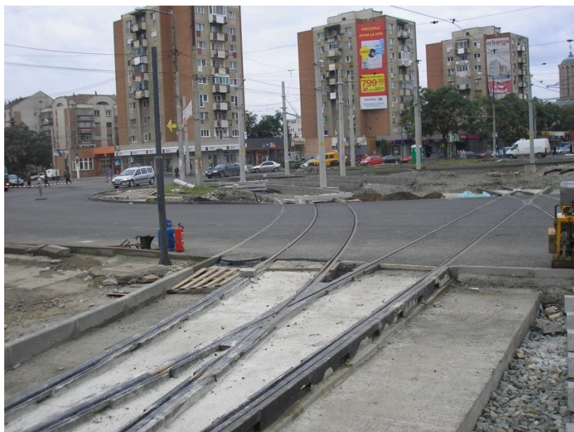
Foto 213. Lucrările de reabilitare tronson Făt Frumos-UTA (2009).
