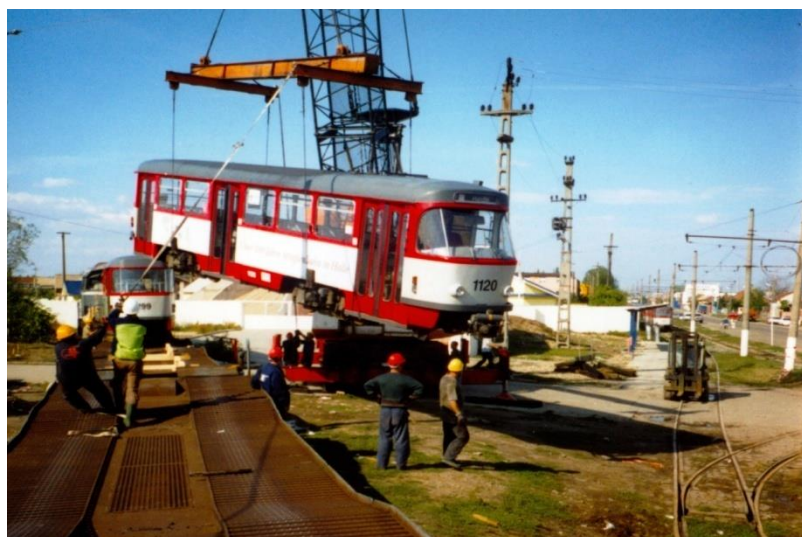
Foto 188. Descărcarea unui vagon T4D, la C-pt. Ignat, în anul 2003.
