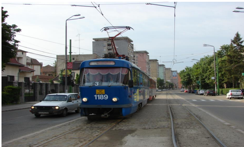
Foto 222 Calea Romanilor înainte de reabilitarea din etapa II
