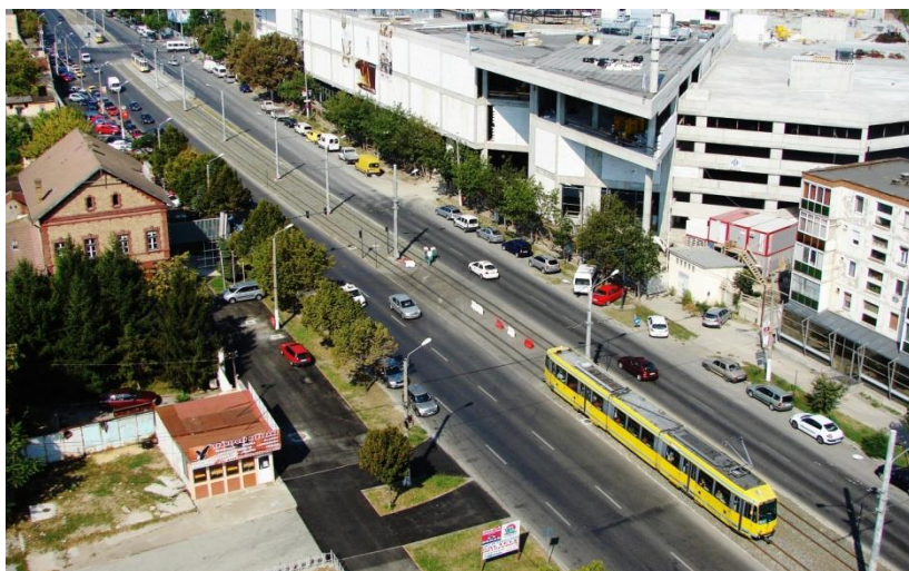
Foto 180. Tramvai M8S, pe tronsonul de linie reabilitat Calea Aurel Vlaicu (imagine surprinsă în anul 2009).
