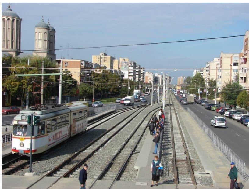
Foto 216. Linii modernizate în cadrul proiectului cu finanțare BERD, etapa I (imagine surprinsă în anul 2009).
