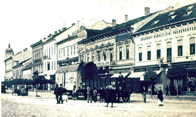
Foto 35. Vagoane de cale ferată cu marfă, în zona străzii Unirea de azi și a depozitelor Andreny.
