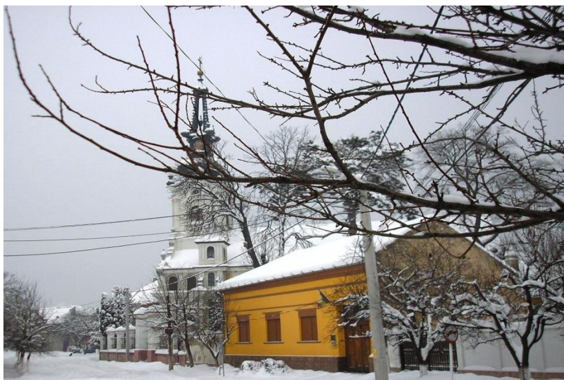
Foto 48. Biserica ortodoxă construită în anul 1790 și renovată în perioada 1928-30 (imagine recentă).
