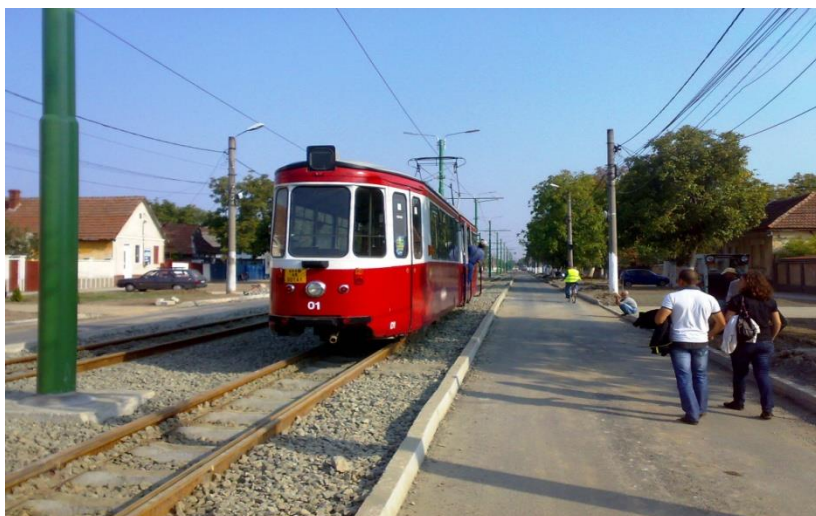
Foto 221. Proba cu tramvaiul la recepția lucrărilor din anul 2012, de pe Strada Renașterii.
