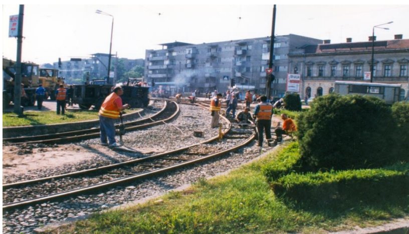
Foto 206. Aspecte de la lucrările din anul 1999, din P-ța Podgoria, imagine cu montarea macazurilor din sensul de venire din Micălaca, respectiv, în imaginea de jos, cu montarea șinelor în curbă.
