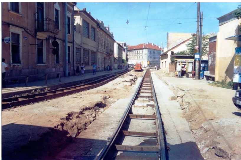
Foto 203. Lucrări de reparație la linie pe str. Tribunalul Dobra, în anul 1996.
