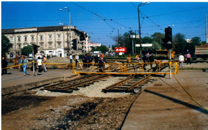
Foto 206. Aspecte de la lucrările din anul 1999, din P-ța Podgoria, imagine cu montarea macazurilor din sensul de venire din Micălaca, respectiv, în imaginea de jos, cu montarea șinelor în curbă.
