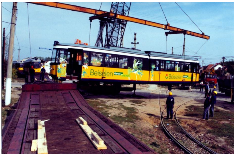
Foto 140. Operațiune de descărcare vagon GT4 în zona Căpitan Ignat, în anul 2003.
