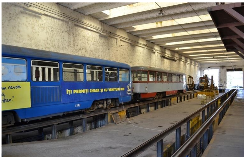
Foto 124. Hală de întreținere vagoane Tatra din depoul UTA, cu liniile ridicate de la nivelul pardoselii, pentru acces facil la echipamentele amplasate la partea inferioară a vagonului.
