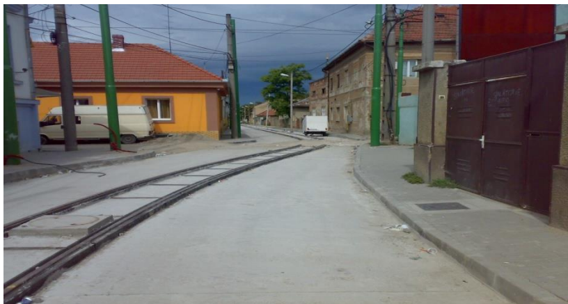
Foto 218 Strada Dornei în anul 2010 ,faza de montare a șinelor
