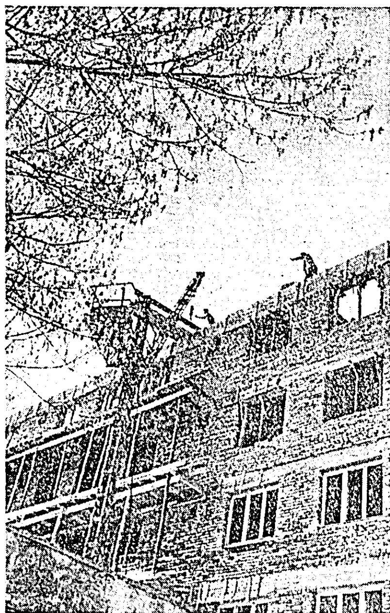
Construcții de pe șantierul blocului de locuințe de pe Bulevardul Lenin nr. 5-7 s-au angajat să dea construcția în folosință oamenilor muncii, înainte de termen. În prezent ei zoresc la terminarea lucrărilor de zidărie ale ultimului planșeu, etajul IV.
