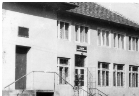
Poșta și dispensarul uman din Păuliș, construit în 1974
