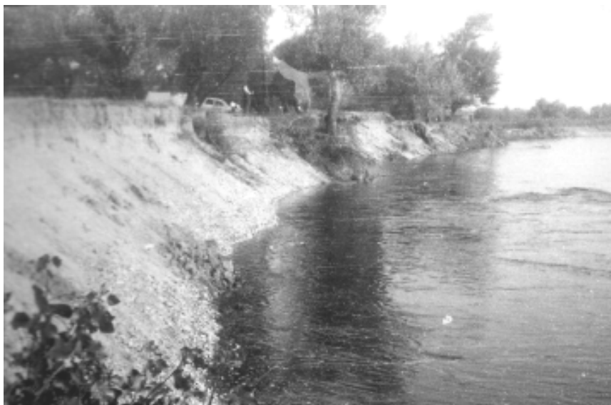
Eroziune laterală în malurile văii Mureșului la Sâmbăteni
