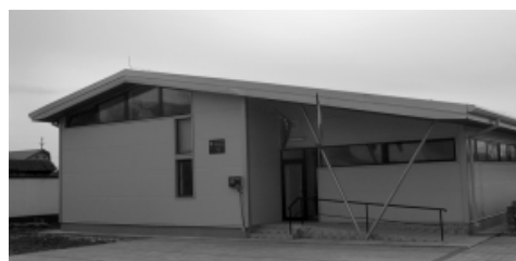
Sala de gimnastică și sport de la Școala Generală Păuliș construită în 2009
