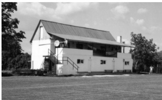
Modernul vestiar al echipei de fotbal „Păulișana Păuliș”, construit în anul 2005
