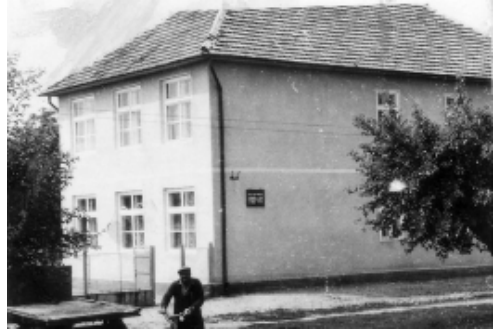
Grădinița cu program prelungit din Sâmbăteni, construită în 1980
