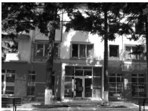
Noul sediu administrativ al Primăriei comunei Păuliș. Clădire în construcție. 2010
