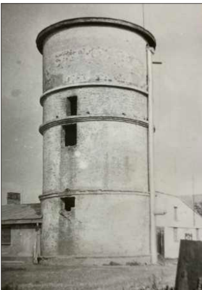
Siloz pentru furaje CAP Viața Nouă
