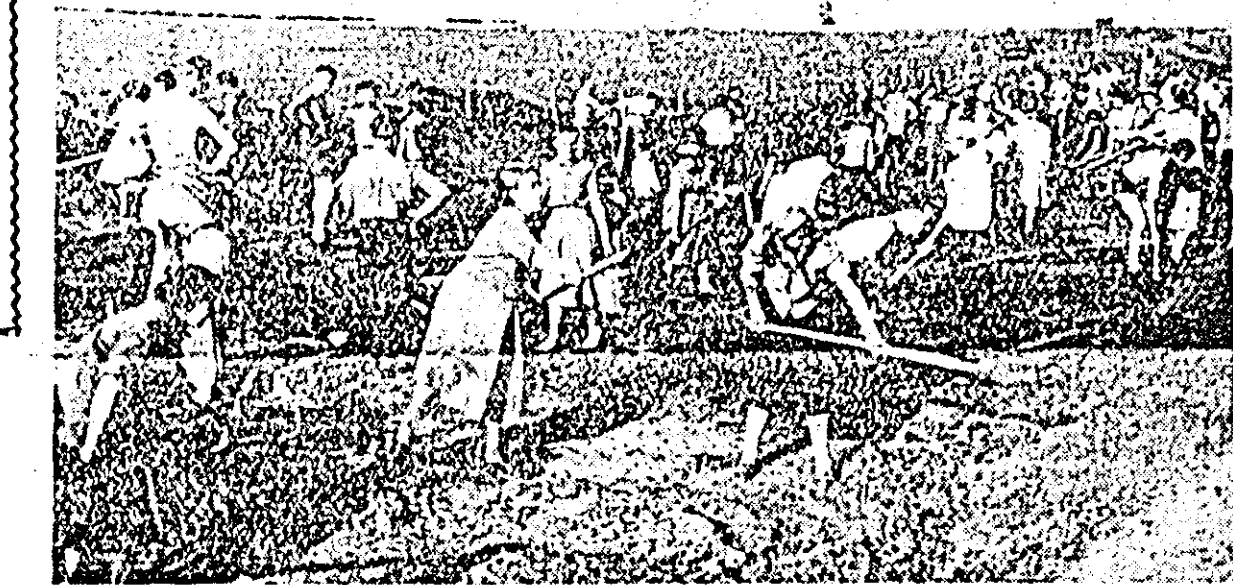
Aspect obișnuit acum pe șantierul marilor artere. Zece, sute, mii de metri cubi de pământ dislocați din loc.
