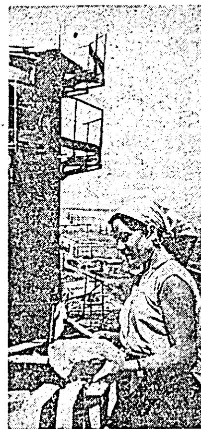
Tinara bulgară Pelka Minkova lucrand la construirea uzinei de zahăr „Noul Bansk” din R. P. Bulgaria.
