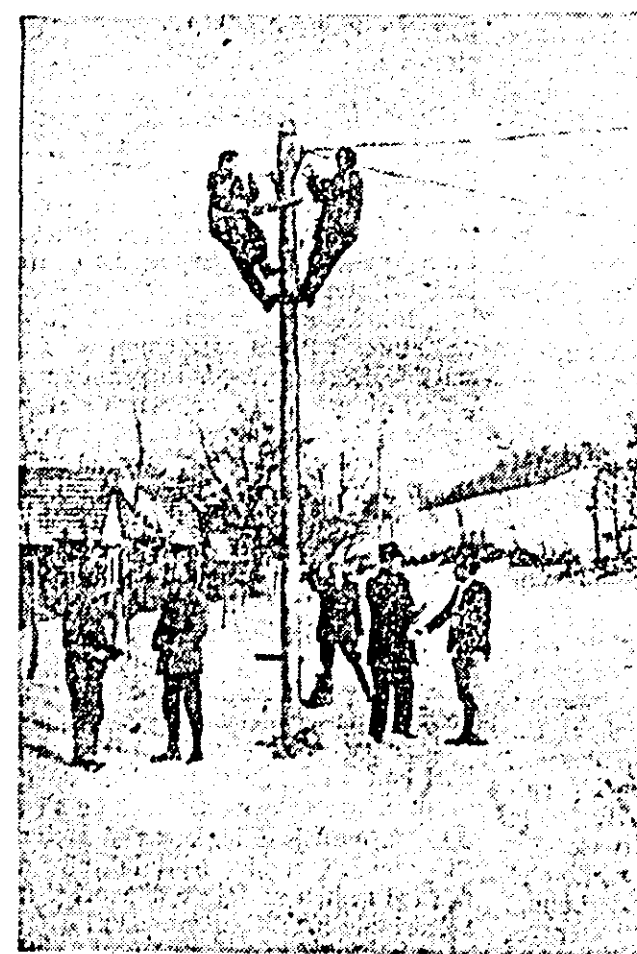
Muncile de instalare a stîlpilor și de întindere a firelor pentru radioficarea în întregime a satului Honțșor, aparținător comunei Gurahonț, s-au încheiat. În clișeu: echipa stației de radioamplificare a comunei Gurahonț care a contribuit efectiv, alături de țărani muncitori din satul Honțșor, la radioficare.
