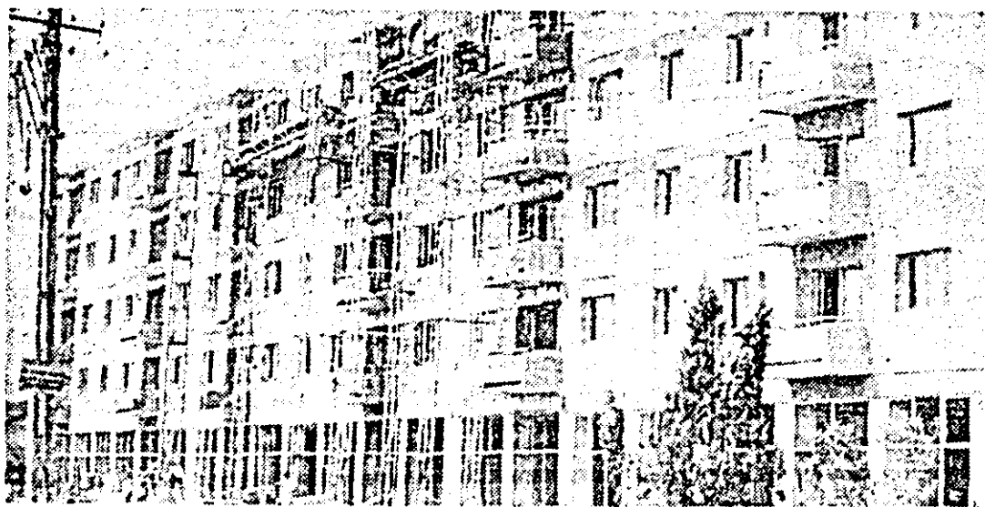
Zestrea edilitară a orașului Ineu se îmbogățește cu noi apartamente pentru oamenii muncii. În imagine: se execută lucrările de finisare la un nou bloc de locuințe, care va dispune, la parter, de noi spații comerciale.
