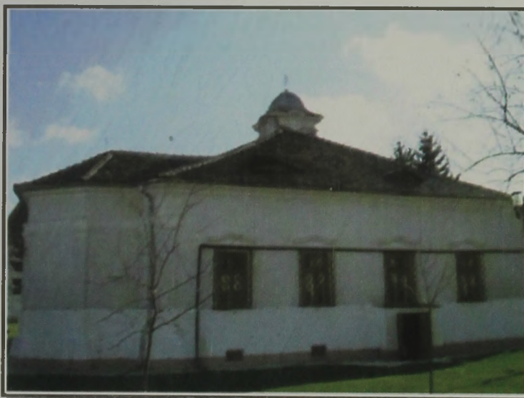
Vedere din partea de nord
