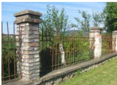
Gard din fier forjat confecționat în anul 1903
