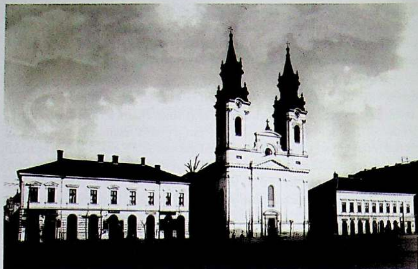
Clădirea de pe latura de nord a Catedralei (1885)
