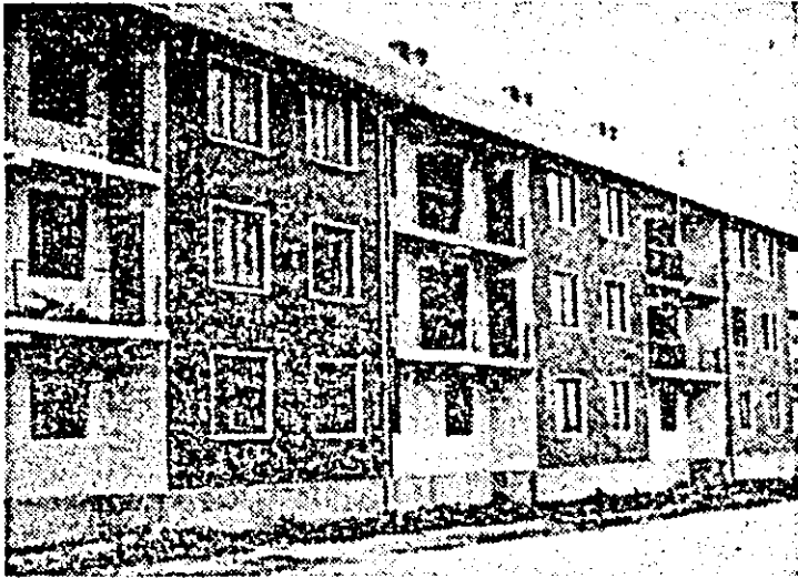
La I.A.S. Uivulș s-a construit un bloc de locuințe pentru specialiști. Foto: M. CANCIU
