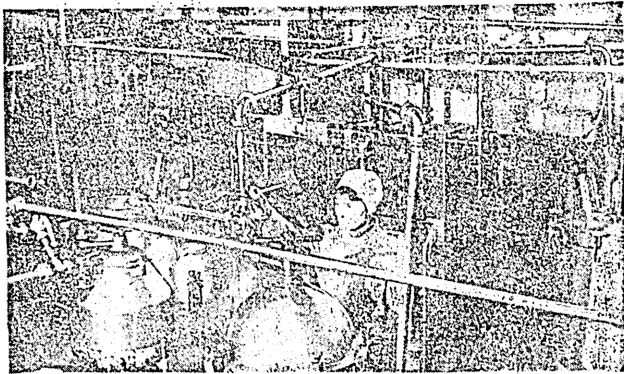
Se reglează parametrii de funcționare a instalației de posteurizare a laptelui din dotarea Unității de industrializare a laptelui, întreprindere de bază a Combinatului alimentar.
