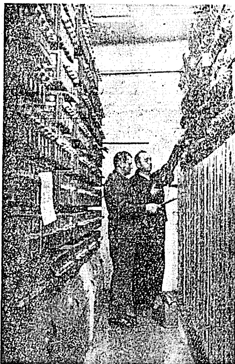
În imagine: electromecanicii Benjamin Suciu și Teodor Socaci din sectorul C.E.D. al stației Arad, verificînd ramele cu rele.
