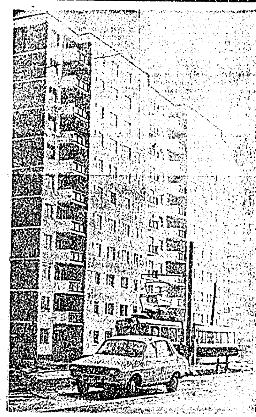
Construcții și-au încheiat mînașca și... un nou bloc cu 10 etaje din cartierul Aurel Vlaicu, cel mai tîrziu cartier al orașului, își așteaptă locuitorii.
