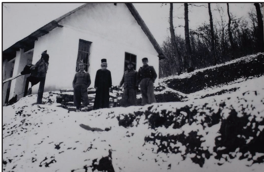
Anexa nr. 28. Mănăstirea Feredeșu – chiliile și unul din viețuitori. (Sursa: Arhiva Mănăstirii Feredeșu)
