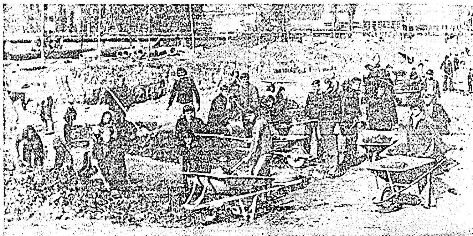
În zona Pasaajului Micălașa pe șantierul-scoală al Liceului Industrial nr. 6 din Arad, elevii claselor II F și I C se întrec în hărnicie.
