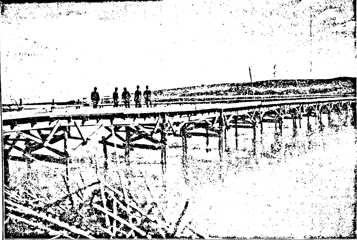
Pod provizoriu făcut în câteva ore:
